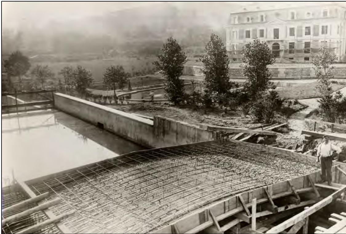
Document 21 : Construction du pont sur la Lièpvrette reliant le parc à la route principale – 1934-1935
