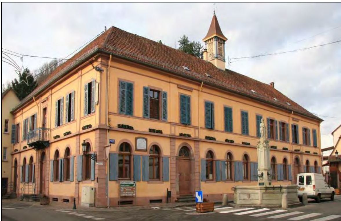
Document 19 : Ecole primaire / école élémentaire de Sainte-Croix-aux-Mines - Photo José Antenat – 2006
