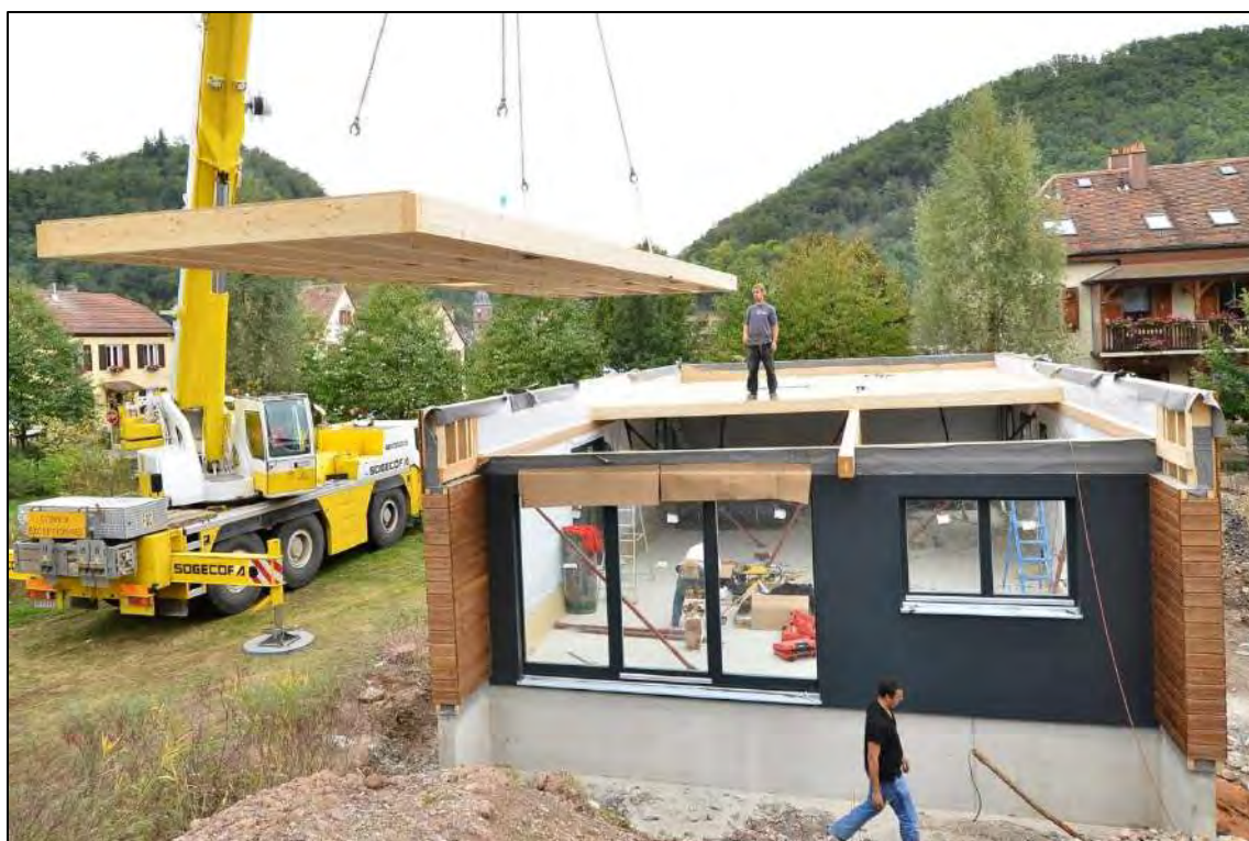
Document 20 : Construction d'une maison Booa
