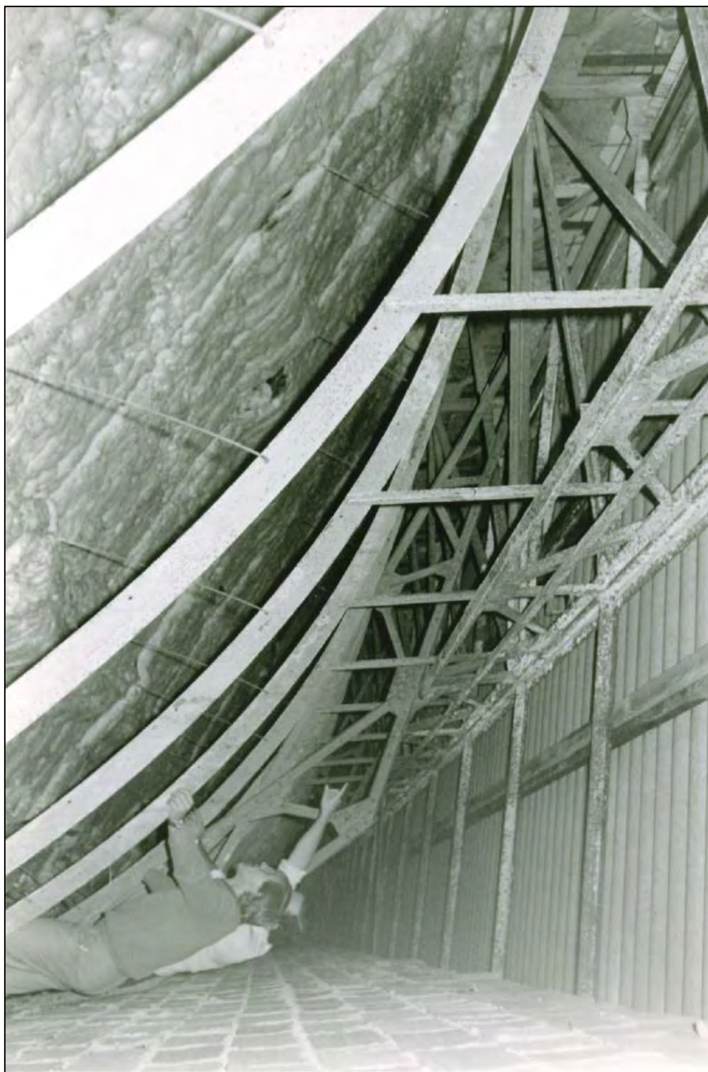
Document 20 : Toiture de la piscine municipale de Sainte-Marie-aux-Mines - Charpente métallique intérieure - Archives SMAM - vers 1984-1985
