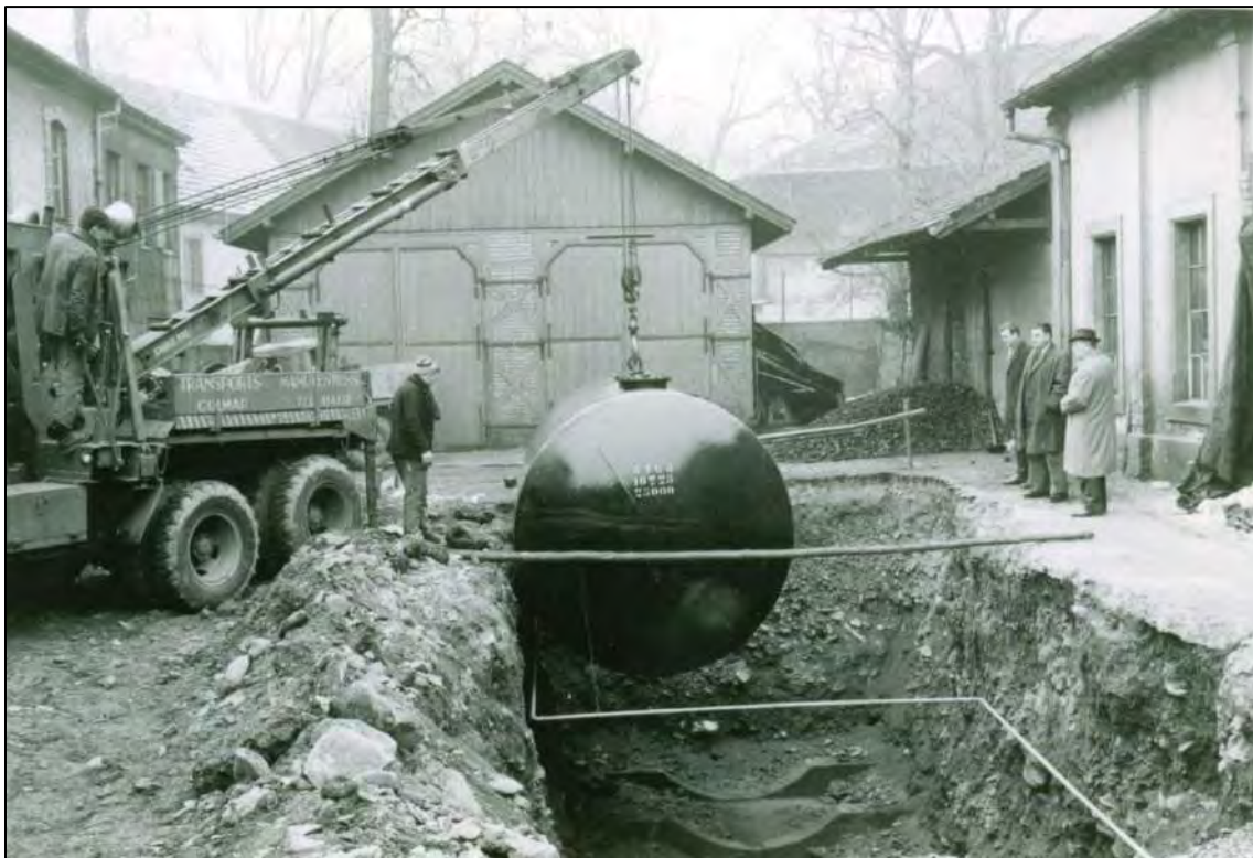
Document 27 : Installation d'une citerne à mazout 1964
